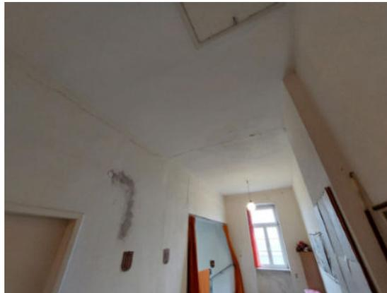
4 statische Mauerwerksrisse im Stiegenhaus OG aufgrund der veränderten Lasten aus dem DG
