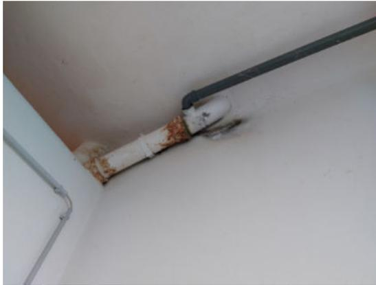
1 Defekte Entwässerungsleitung Knaben
