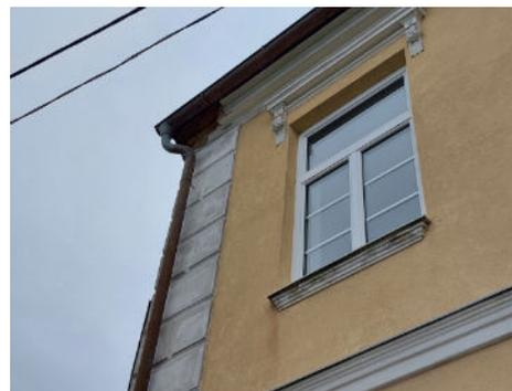
7 Feuchteschaden durch mangelnde Entwässerung (Südfassade)
