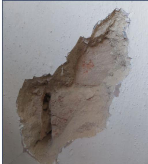
Die Öffnung eines Risses im Gangbereich des Obergeschosses, um die Tiefe des Risse und den Umfang des Schadens abzuklären. Der Riss reicht nur bis in die Putzschicht, das Mauerwerk bleibt unversehrt.
